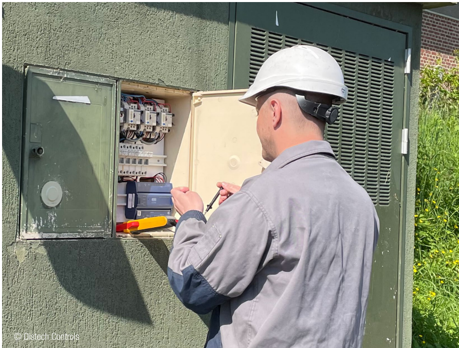
USEDAROC-Schaltschrankinstallation. USEDAROC electrical panel installation.
